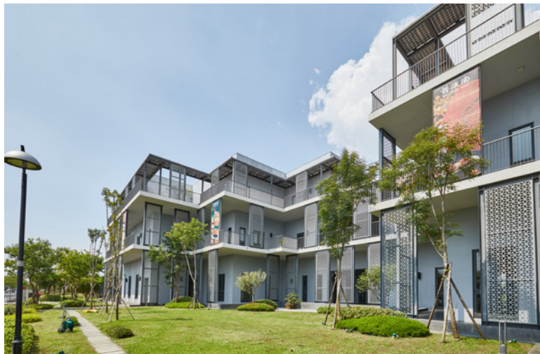
舊振南綠建築總部
